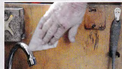
▲ Passer l'acétone sur la surface concernée. Attention, pas sur du plastique, il fondrait !
