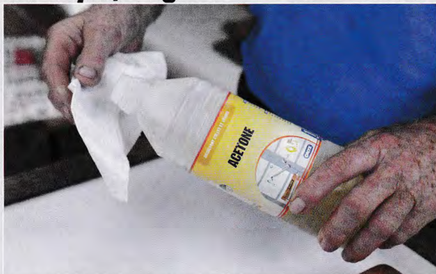
▲ Avant de coller une bande de Velcro ou autre, il faut nettoyer et dégraisser la surface pour assurer une meilleure adhésion. Ne pas appliquer d'acétone sur du plastique ni du plexi !
