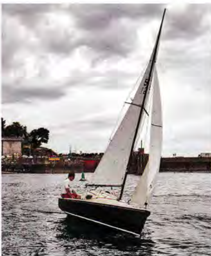
Marémotrice. L'usine, au fond, conditionne la navigation sur la Rance.
