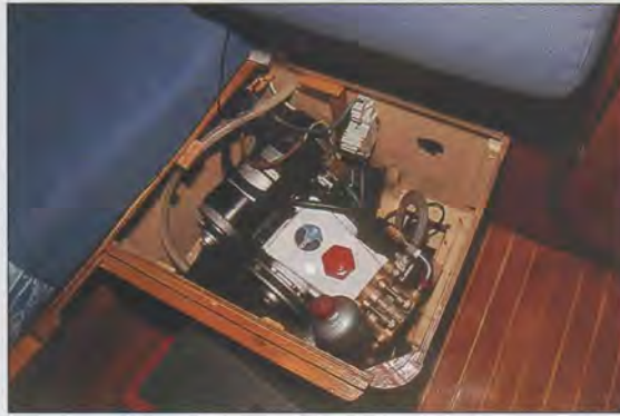
A bord de ce Feeling 10.90, le moteur du dessalinisateur et le circuit haute pression ont été séparés pour s'adapter à la géométrie des coffres.
