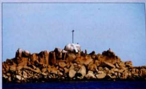
La balise du Rocher Blanc, repérable à sa bande blanche et surmontée d'une perche.
