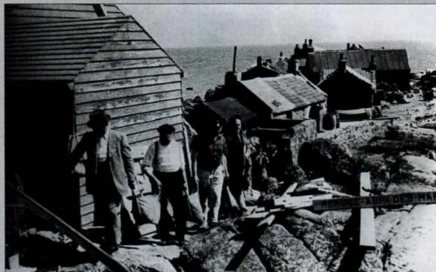
Le troisième homme de la file est le peintre Marin-Marie qui, pendant trois jours, va participer à la construction d'une maison en bois baptisée Refuge-abri des marins français.
