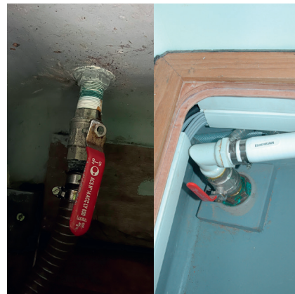
sous marches CAT / sous plancher toilettes
