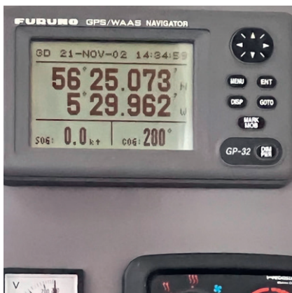
derrière tableau électrique
