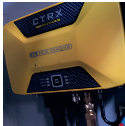
derrière tableau électrique
