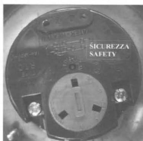
Régler le thermostat en positionnant la flèche du couvercle de réglage de manière à ce qu'elle corresponde à la température indicative désirée. (Réglée par notre production à 60°C).
