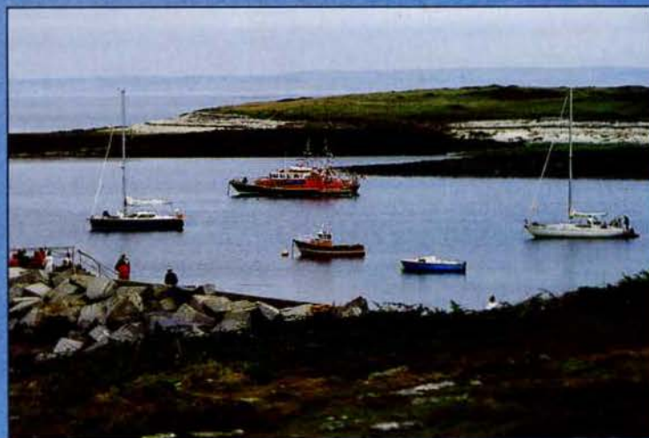
Môle du Bon retour. C'est à l'abri de celui-ci – appelé aussi la Grande digue ou digue neuve – que se niche le port de Molène, protégé à l'Est par Lédenez Vraz.
